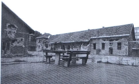
Vandalizem rušilcev: Menza, 10. septembra 1993 zjutraj
