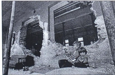
Poškodovane stavbe nekdanje vojašnice na Metelkovi še vedno pričajo o skrivnih posegih (tudi uradno) vedno bolj znanih storilcev. (Foto: Tomaž Skale)
